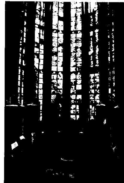
Abb. 10: Der gotische Hochchor des Domes mit den zerstörten Fenstern und dem Bombenschaden im Maßwerk.
